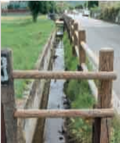
> Sistema canalizzazioni Balangero
