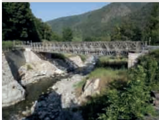
Ponte presso fraz. Forno di Lemie, Lemie (Sotto)
