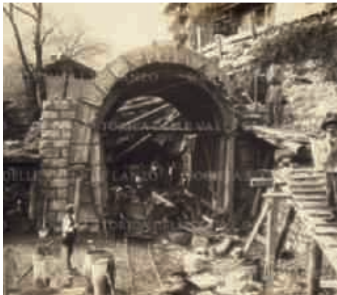
Foto storica sulla costruzione della galleria ferroviaria Rosello (Traves), 1914-1915
