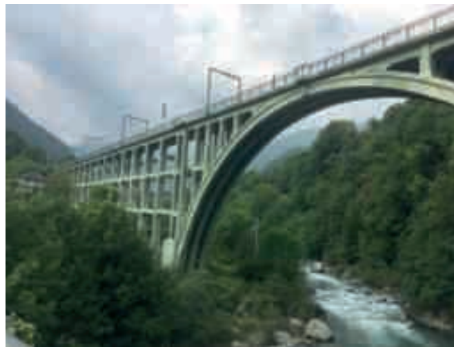
Viadotto Torino Ceres (Sopra)
