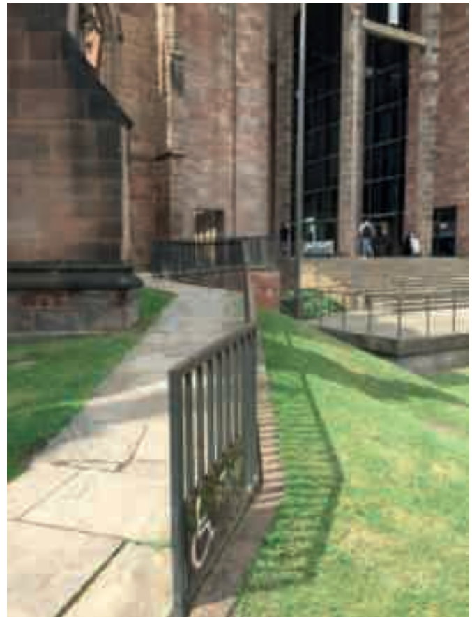
Esempi di rampa con corrimano
