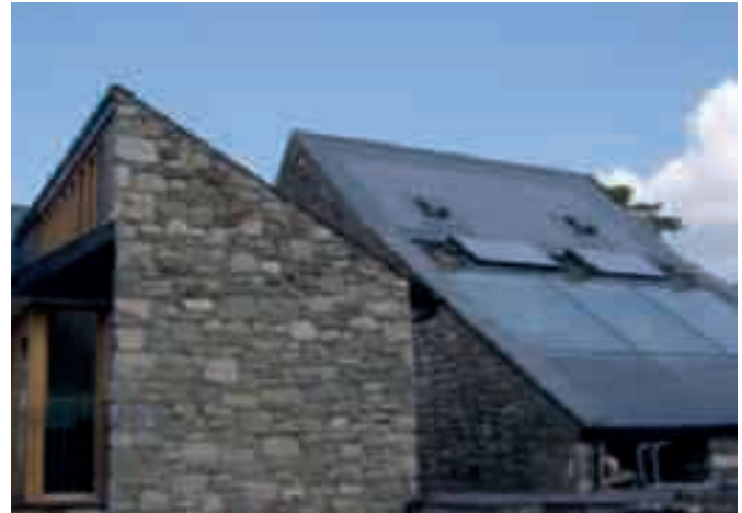
Esempio di pannelli fotovoltaici e solari termici correttamente inseriti nella composizione della copertura e del fabbricato.
